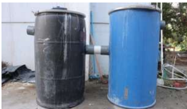
Gambar 1. Tampak depan tangki septik bio-porta dalam skala lapangan.
