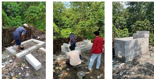
Gambar 6. Proses pembuatan Rocket Stove
