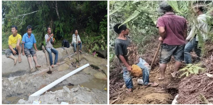
Gambar 3. Gotong Royong Dalam Perawatan Pipa.
