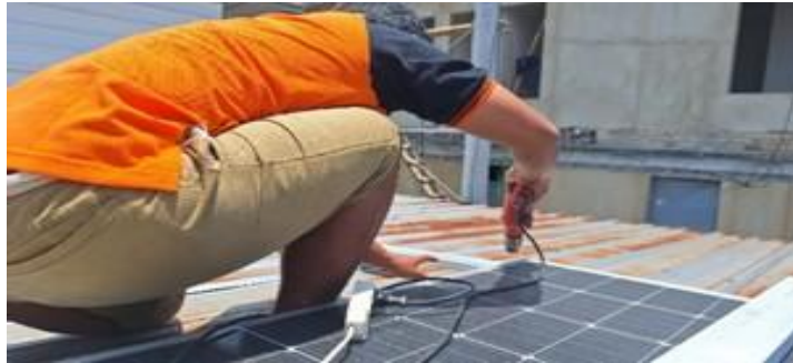
Gambar 2. Pemasangan Solar Panel.
