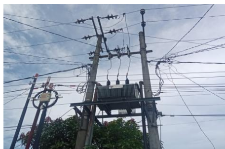
Gambar 4. Transformator Distribusi 160 kVA
